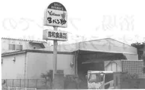
千葉県松戸市にある本社工場
